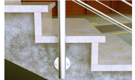
Fissaggi in luoghi chiusi e abitati.
