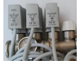
**NB: Il collettore in ottone dotato di flussometro deve essere obbligatoriamente montato sulla mandata del circuito idraulico.**
